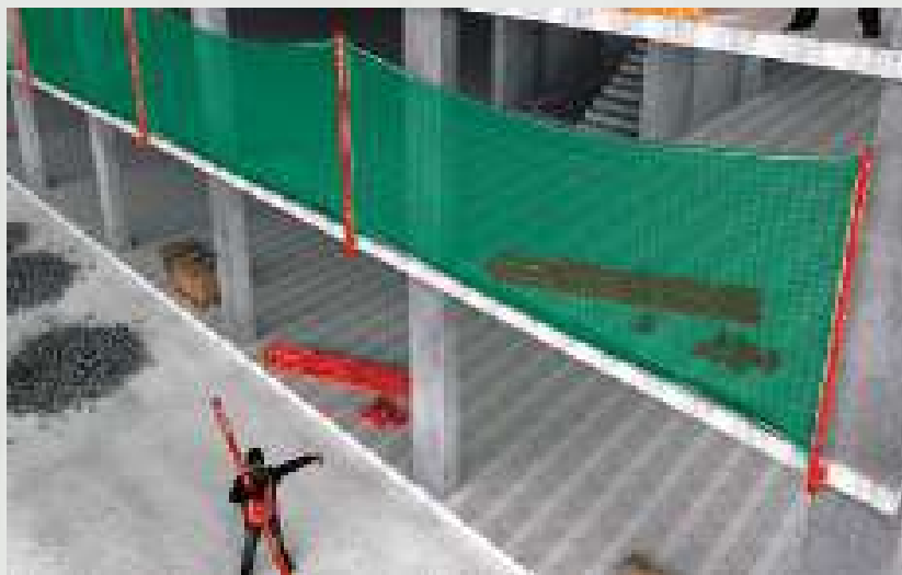
Moduł LiteMESH w konfiguracji mocowania czołowego.
