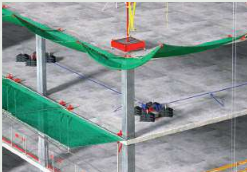
Linia życia podpięta do balastów bezwładnościowych „SPIDER”.
