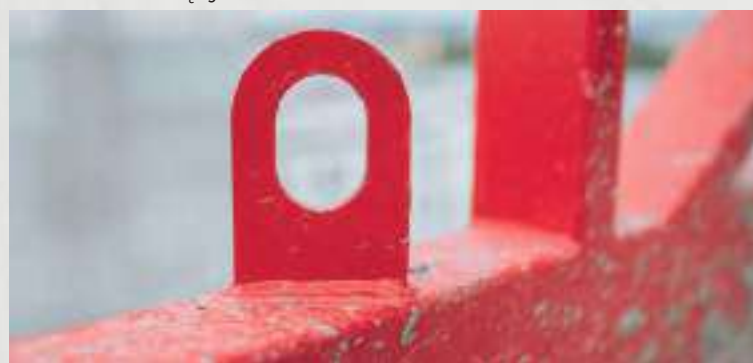
Mocowanie zawiesia dźwigu.
