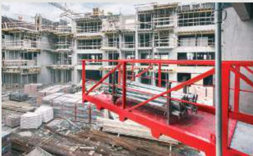
Nośność 4 tony, podłoga podestu równa z poziomem stropu zapewnia ergonomię w użytkowaniu.
